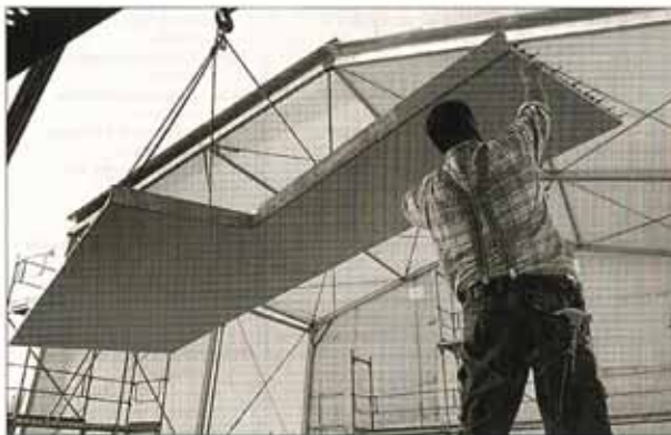
Hausbau in einem riesigen Zelt: Auf den Baustellen der Firma Viebrockhaus soll auch im Winter und bei Minusgraden Betrieb sein.
