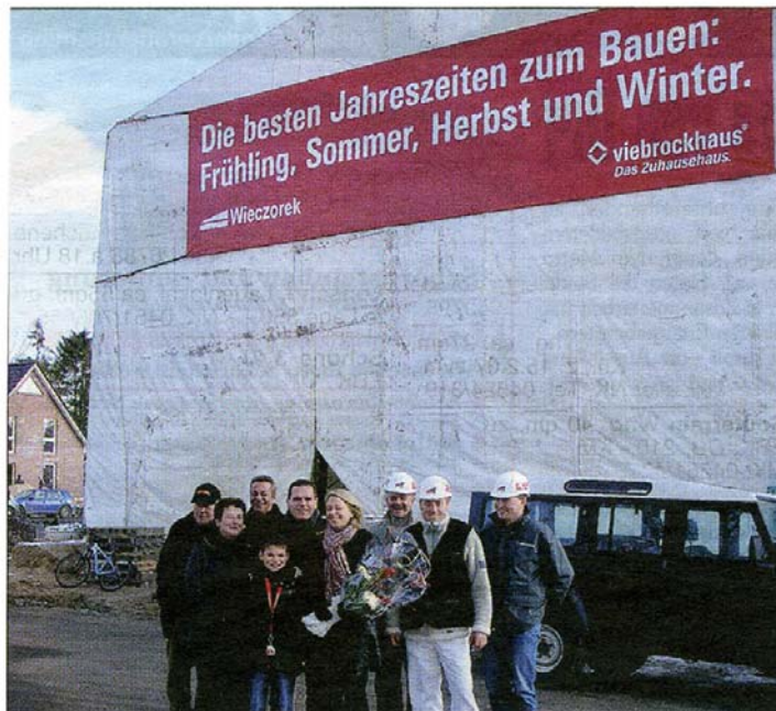
In Stockelsdorf wird ein modernes Massivhaus unterm Zelt gebaut.
