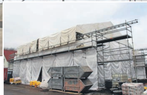
Stefan Nienaber und Dirk Paulus stehen im ersten Stock des Wohnhauses am Nelson-Mandela-Weg im Baugebiet 70. Noch haben sie kein Dach, dafür eine Zeltplane über dem Kopf. ■ Fotos: nkö
