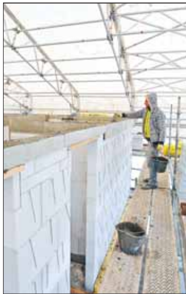
Stein auf Stein baut hier, im „Sterzwinkel“, Viebrockhaus ein Haus unter einem Zelt, das vor Nässe und Kälte schützt. Fotos: Dorn
