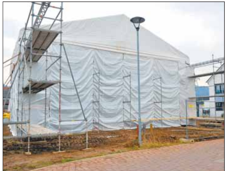
Stein auf Stein baut hier, im „Sterzwinkel“, Viebrockhaus ein Haus unter einem Zelt, das vor Nässe und Kälte schützt. Fotos: Dorn
