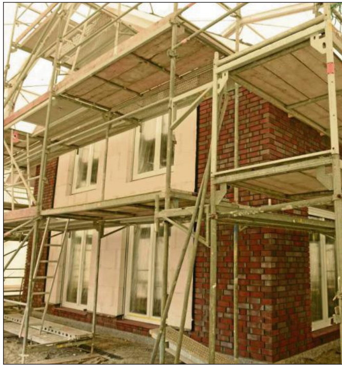
Ein Blick unter das 16 mal 20 Meter große Zelt verrät: Hier entsteht ein Eigenheim in Massivbauweise.
