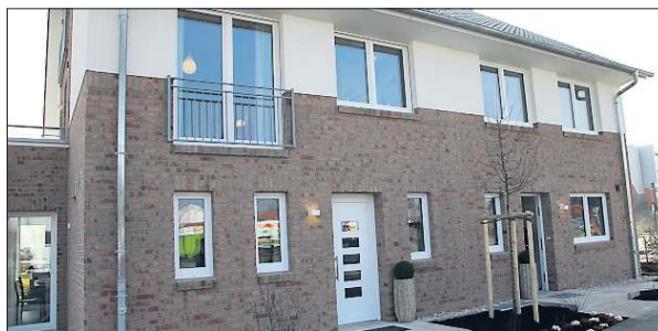
Das neue Doppelhaus im Musterhaus-Park erfüllt neueste Energieparverordnungen. BILD: CALLIES
