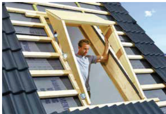
Beim Sparrendach geben die Abstände zwischen den Sparren die Fensterbreiten vor. Velux
